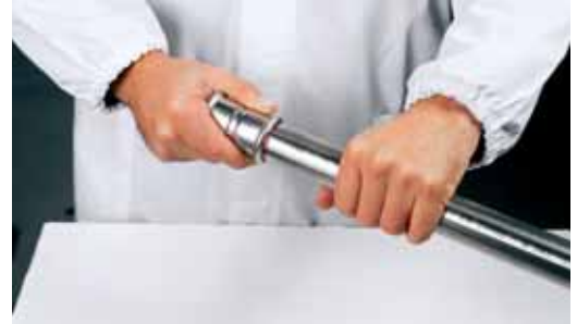
21.ábra – A cső behelyezése a présidomba
