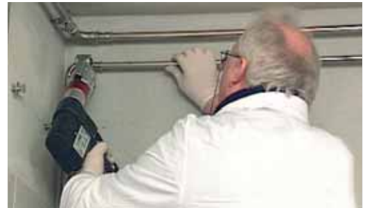
22.ábra – Sajtoltsökötet kialakítása
