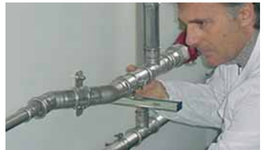
23.ábra – Sajtoltsökötet ellenőrzése
